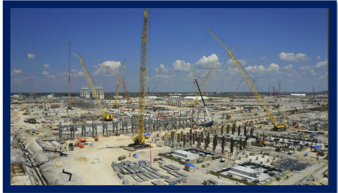
Image Courtesy of Golden Pass LNG
